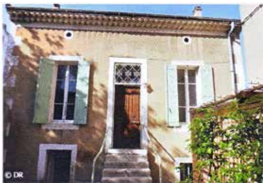
L'immeuble en l'état actuel...
